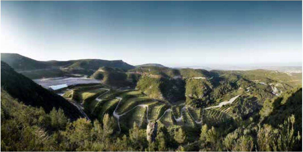
Fig. 4 – The El Garraf Massif, Barcelona. Project for a community park on the Val d'en Joan landfill drawn up by the architects Enric Batlle and Joan Roig (source: Batlle I Roig Arquitectes archives).
