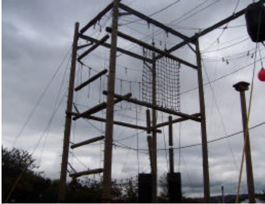
Figura 4. struttura per arrampicate in sicurezza.
