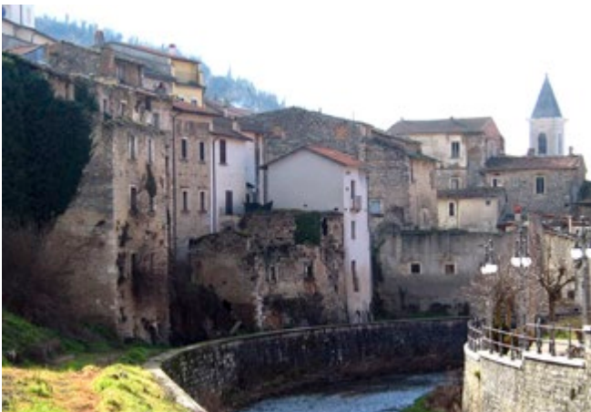
Figura 3. Edifici lungo la riva del fiume Giovenco (foto Novembre 2016).
