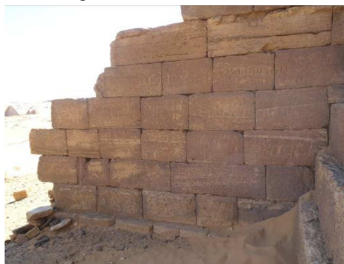
Fig. 18. Le «mur des dédicases à Méroé
