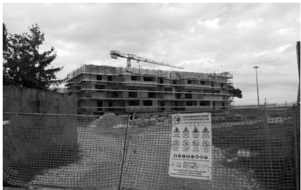
Fig. 3. Gli edifici 'volano' in costruzione.
