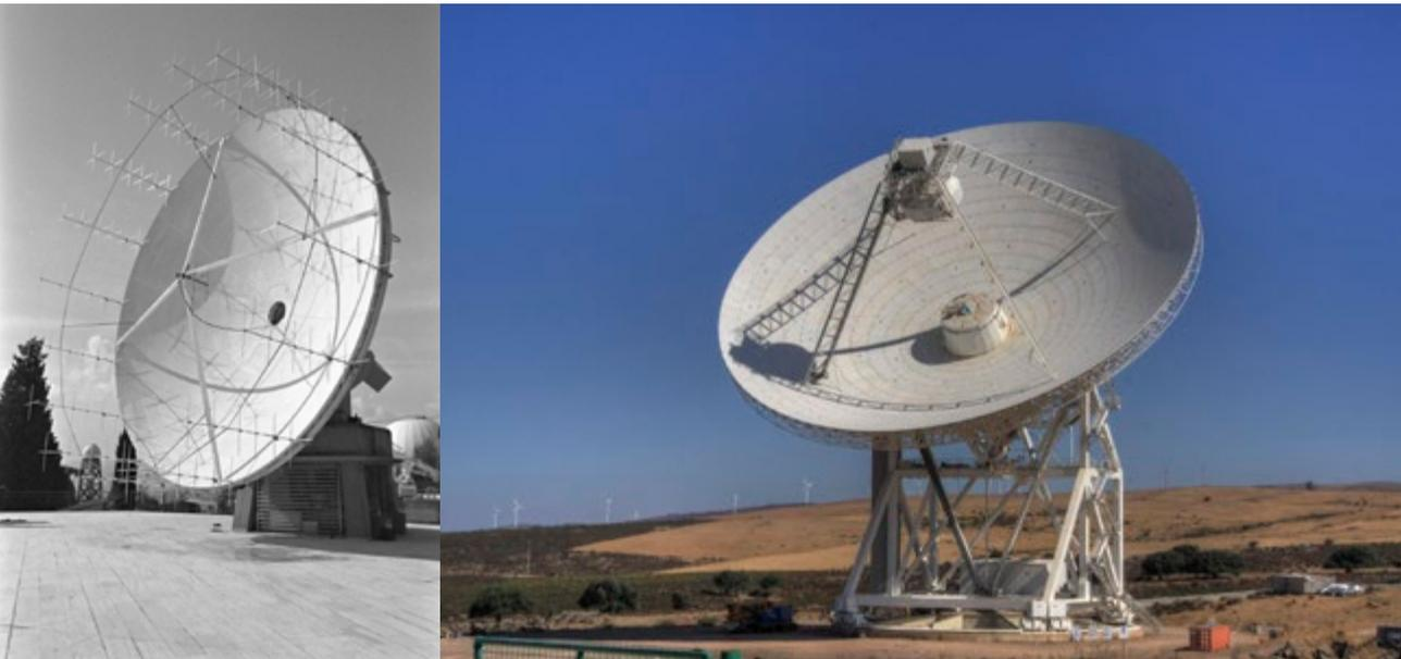
Figura 2. A sinistra il radiotelescopio solare sulla terrazza dell'Osservatorio di Arcetri (foto del 1977). L'antenna è stata a lungo utilizzata per osservazioni solari alla lunghezza d'onda di 3 cm (10 GHz), mentre i dipoli permettevano l'osservazione di un satellite che trasmetteva dati d'interesse per lo studio dell'emissione X del sole. A destra il grande radiotelescopio della Sardegna in fase di completamento (foto del 2011).
