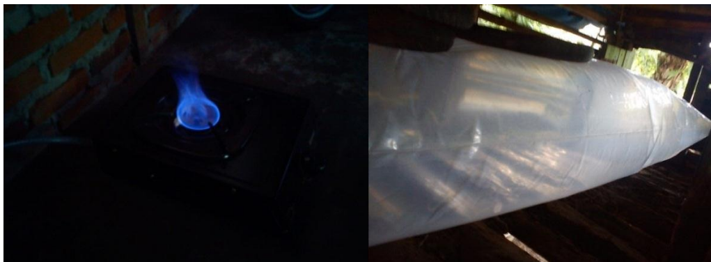
Gambar 9. Hasil instalasi biogas. (a) Penampung gas yang sudah terisi gas, (b) gas yang dihasilkan
