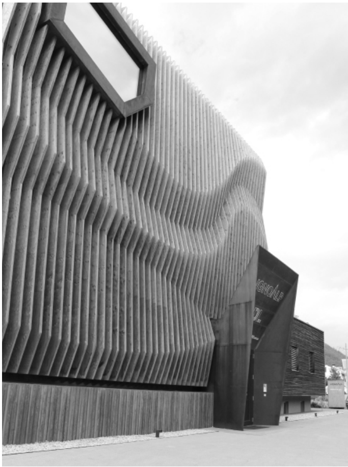
02 | Sede LignoAlp a Bressanone, 2011, Modus Architekt (Sandy Attia e Matteo Scagnol), progetto impiantistico Energytech (Felderer & Klammsteiner), foto di Michela Toni. Ha ottenuto il marchio "CasaClima Work&Life" per ambienti di lavoro sostenibili sulla base di criteri di gestione coerenti con uno sviluppo consapevole e rispettoso delle risorse e delle persone
