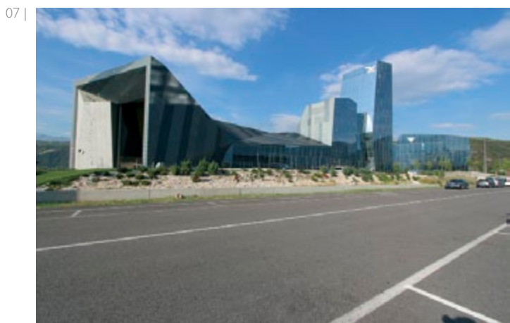
07 | Salewa Headquarter a Bolzano, 2011, Cino Zucchi Architetti, Park associati, progetto impiantistico Energytech (Felderer & Klammsteiner), foto di Michela Toni. La sensibilità ecologista dell'azienda ha ispirato un progetto che ha portato alla quasi totale eliminazione di emissioni di anidride carbonica e all'autonomia energetica, in base al controllo e alla scrupolosa riduzione dei consumi, allo sfruttamento dei sistemi passivi, all'adozione di sistemi attivi di risparmio energetico, uniti ad un impianto fotovoltaico che ha una potenza di 380 kW pv , genera 440.000 kWh di energia elettrica ed evita emissioni di 330 tonnellate di CO 2 . L'intervento è innovativo anche rispetto a criteri economici e di cultura sociale. Offre servizi ai propri dipendenti (mensa, asilo nido, palestra) e ai lavoratori delle aziende confinanti (asilo nido), oltre a strutture sportive agli amanti dello sport (palestra per arrampicata, ferrata per principianti, spazi per bouldering e per allenarsi con la piconazza) e spazi verdi e punto ristoro per tutti coloro che vogliono usufruirne
