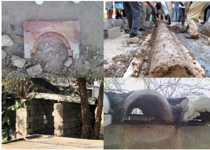
08 | Da sinistra a destra e dall'alto in basso: sagome di legno per la profilatura dei tegoloni all'intradosso e all'estradosso; profilatura della forma inferiore; vista del sito di esercitazione durante una pausa; dettaglio dei tegoloni durante l'applicazione del conglomerato di segatura e cemento all'estradosso. (Foto: Gian Luca Brunetti, licenza Creative Commons)
