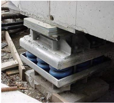
Fig.3.1. Base isolation technique.
