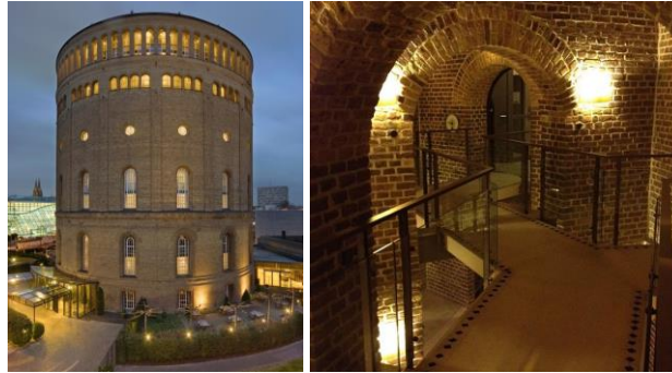
Fig. 6 Hotel im Wasserturm, Cologne: a) hotel building; b) interior detail
