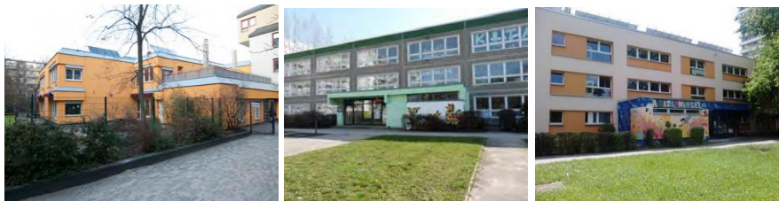
Fig. 2 Day care centre Wolgaster Strasse after renovation (left); Day care centre „Akazieninsel“ in Marzahn before and after reconstruction (right) (Source: http://www.stadtentwicklung.berlin.de/umwelt/umweltentlastungsprogramm/download/broschuere_10_jahre_uep_en.pdf )
