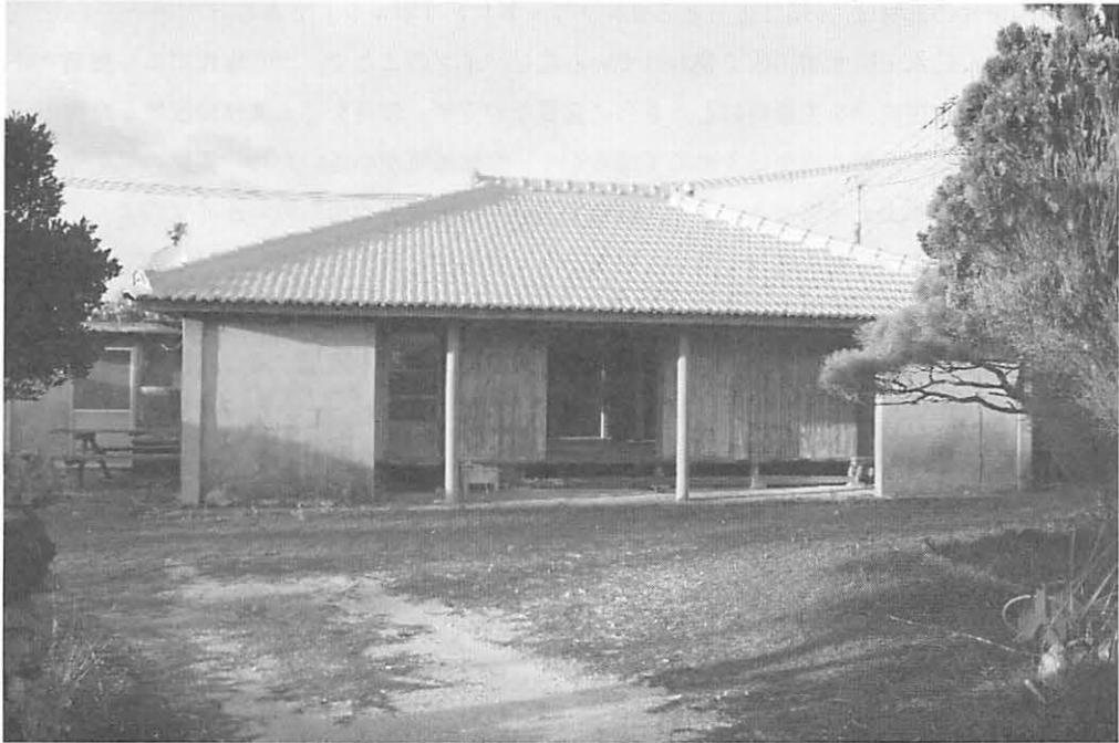
図6.7 コンクリートブロックで四隅を補強した木造住宅の雨端
