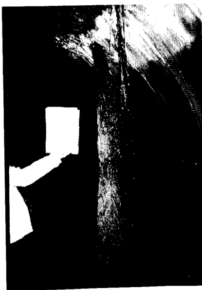
Fig. 17 La penetrazione di acqua dall'estradosso della galleria, durante una interruzione dell'esercizio e lo svuotamento dal canale, indica le notevoli soluzioni di continuità, prodottesi per forti deformazioni subite o per vetustà lungo il Canale Principale dell'E.A.A.P
