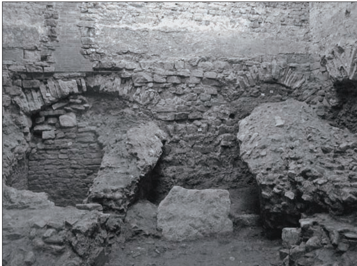
Fig. 10. Parete ovest dell'ambiente V. Al centro dell'immagine è visibile l'ingresso alla platea del teatro e la volta della burella sfondata; tra i muri radiali fu poi costruito un plinto su cui scaricano due archi di sostruzione che sorreggono un edificio di XIII.
