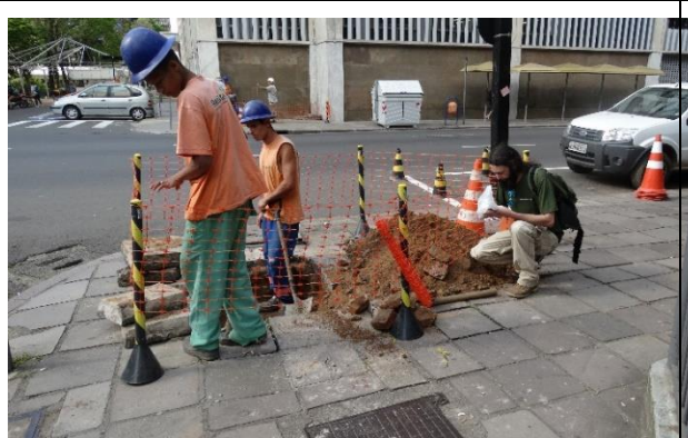
Foto 3 - No detalhe: Monitoramento arqueológico da atividade de abertura e escavação para a instalação da estrutura da caixa da Rua Siqueira Campos, quase esquina com a Rua Capitão Montanha, coordenadas de localização geográfica UTM 22J 477606 / 6677988.
