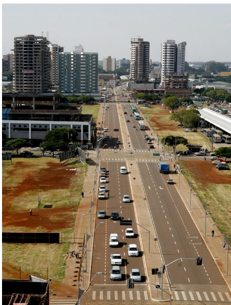
Figura 04: Av. João Paulino Vieira Filho sobre o túnel da RFFSA – Novo Centro, 2010;
