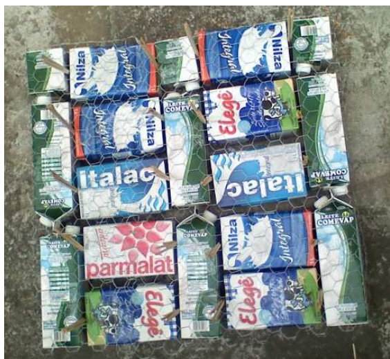
Figura 1 – Caixas tetrapak lacradas e envoltas na rede de arame antes de serem posicionadas na forma
