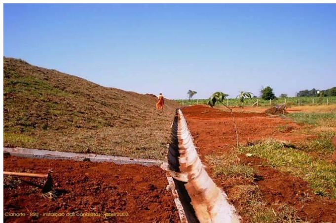
Figura 12 – Canaletas de concreto utilizado no sistema de drenagem de águas pluviais [15]
