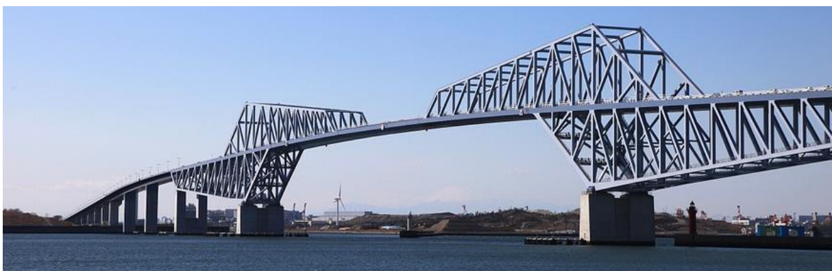
1. ábra: Tokyo Gate Bridge oldalnézete – BHS500 és BHS700 anyagból készült [1].
