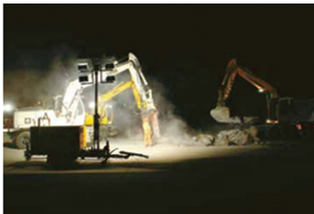
Éjszakai üzemszünet alatti burkolatfeltörés
