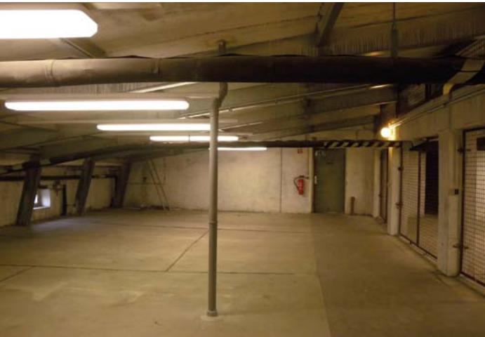
Abb.: Dachgeschossmagazin vor der Sanierung
