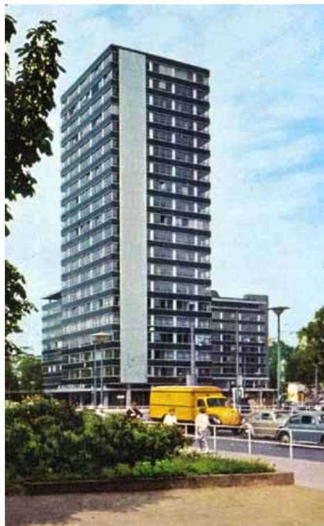
Abbildung 10: Zürich-Hochhaus, Frankfurt am Main 5
