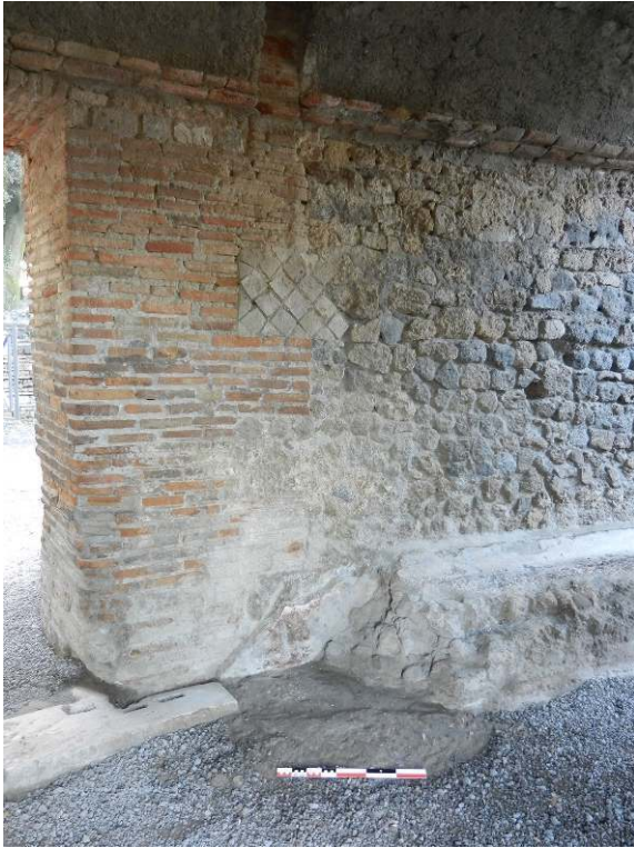
Fig. 15 – Descente d'eau en terre cuite provenant de l'étage supérieur au niveau du départ de la rigole maçonnée de la crypta , dans l'alignement du mât n. 9.
