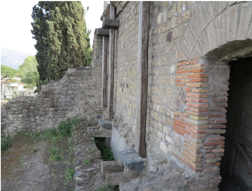
Fig. 5 – État actuel des structures antiques dans l'angle sud-ouest de la summa cavea .
