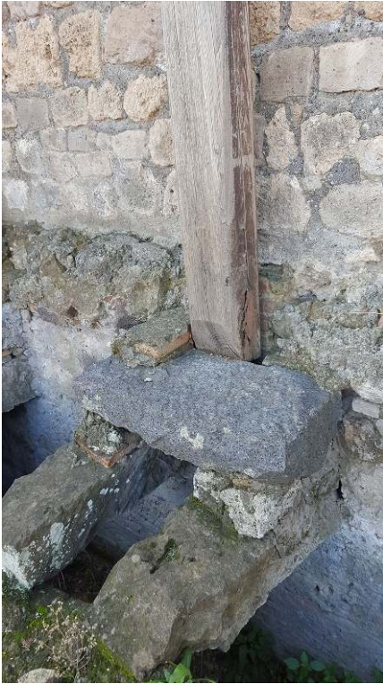
Fig. 13 – Deuxième support maçonné au-dessus de la structure creuse, la ligne de terre cuite est visible derrière le mât en bois.
