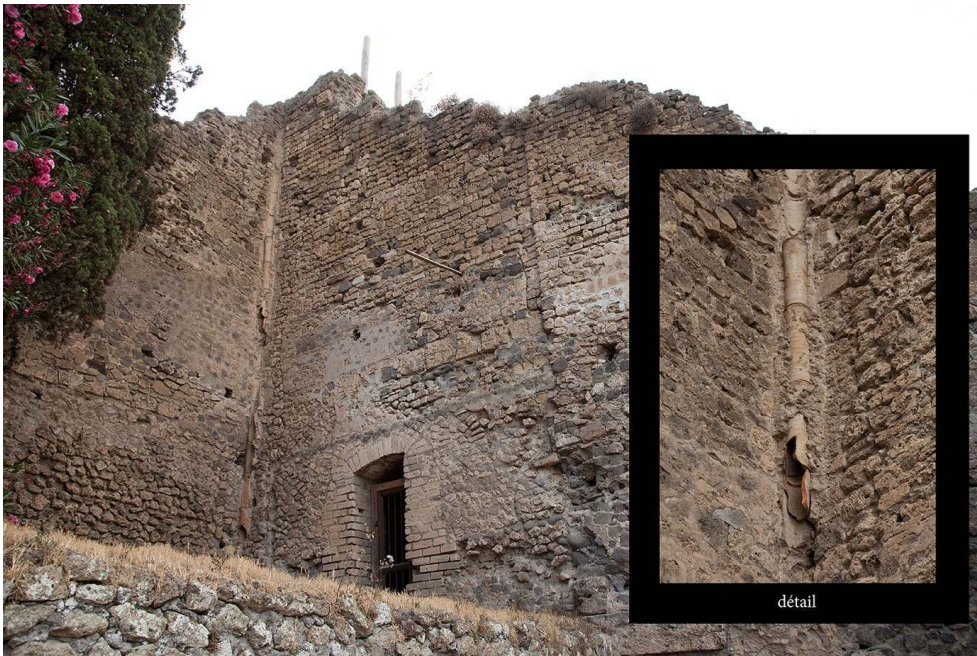
Fig. 9 – Angle sud-ouest de la cavea vu depuis le sud, au niveau de circulation de la terrasse intermédiaire entre théâtres et forum triangulaire, avec une vue de détail de la descente d'eau.
