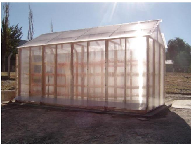
Figura 1: Secador-invernadero de policarbonato.
