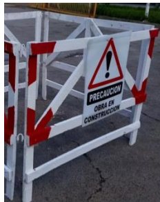
Fijación de señales a las vallas
