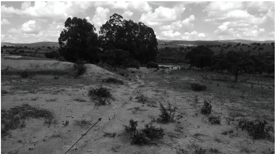
Figura 3. Sangradouro da barraginha na lateral da parede dela.
