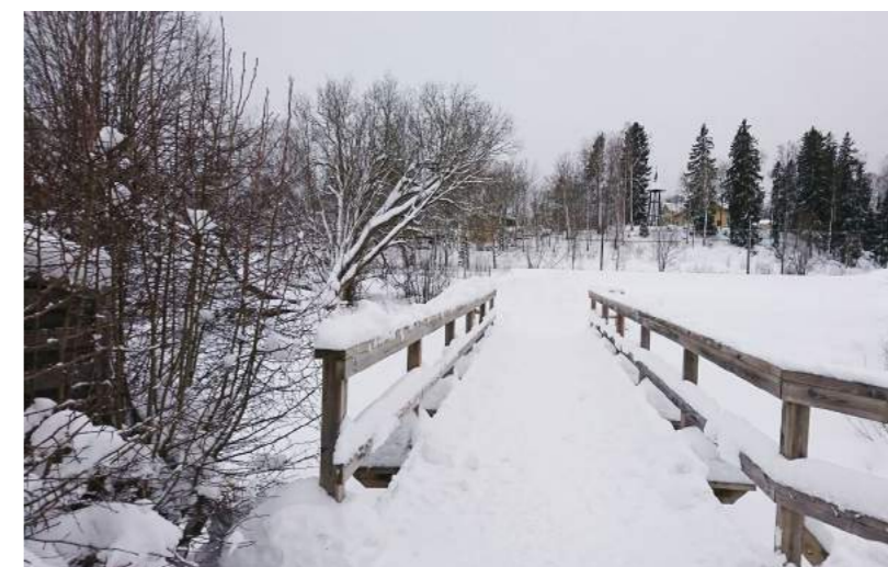
Figur 06. Entrén vid brandtornet var täckt av snö vid de första platsbesöken.
