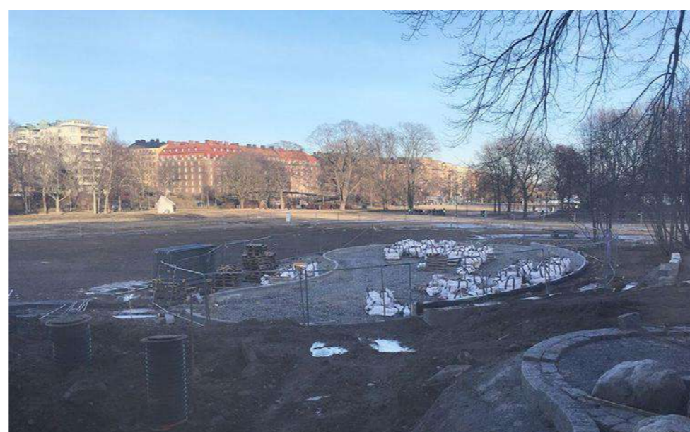
Bild 18. Upprustning pågår i Rålambshovsparken. Dagvattenanläggning placeras i parkens kant för att bevara det öppna landskapsrummet.
