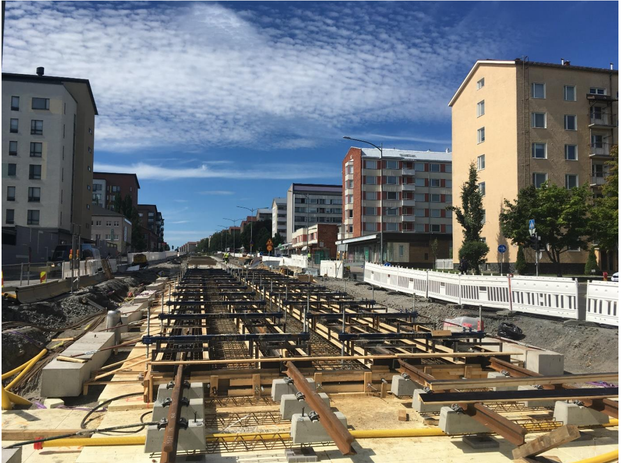
Kuva 42: Sammonkadun ratikkatyömaa Tampereella kesällä 2018.
