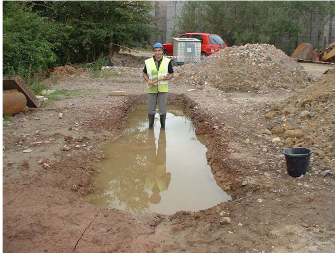
Fig. (20). "inspecting" the CLSM pour.
