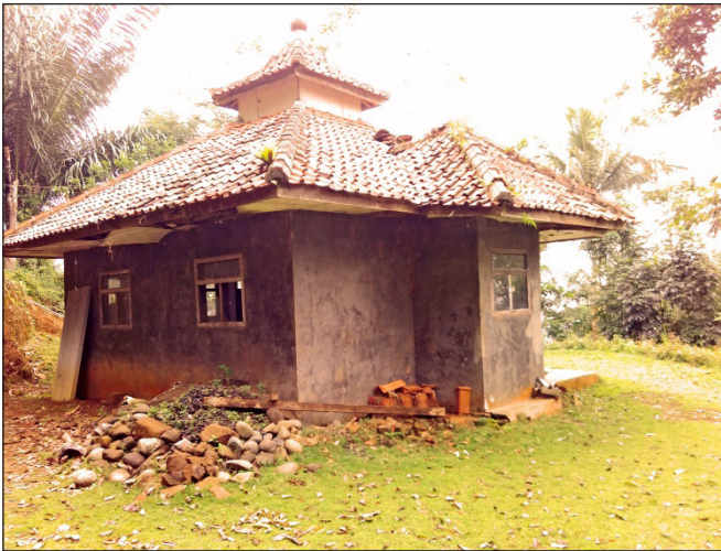
Gambar 3.5 Kondisi mushola Tajakembang Sumber: Dokumentasi Penulis
