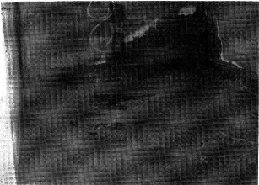
Lantai cor beton dan dinding dari conblok
