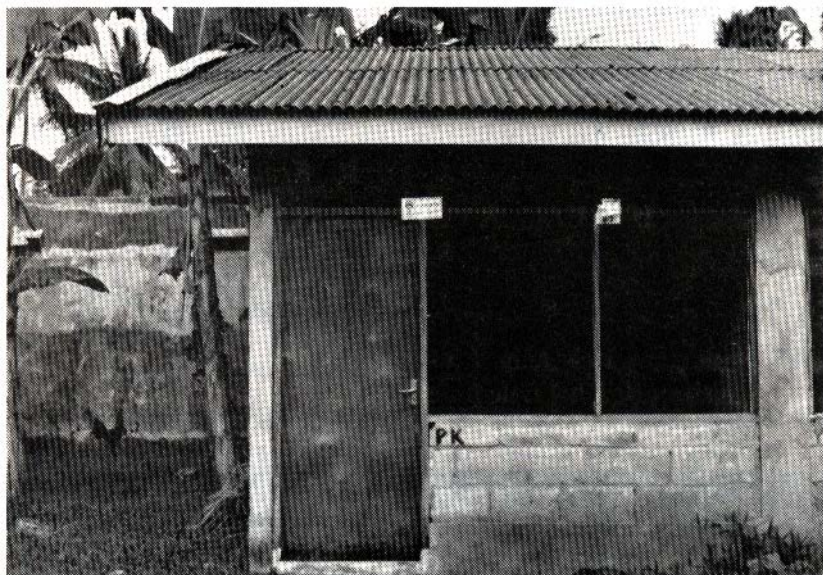
Rangka atapnya menggunakan kayu Kalimantan dan atapnya menggunakan asbes gelombang mini.
