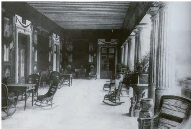
Figura 18. Interior de la casa principal de la hacienda. Fuente: Anaya, 2004.
