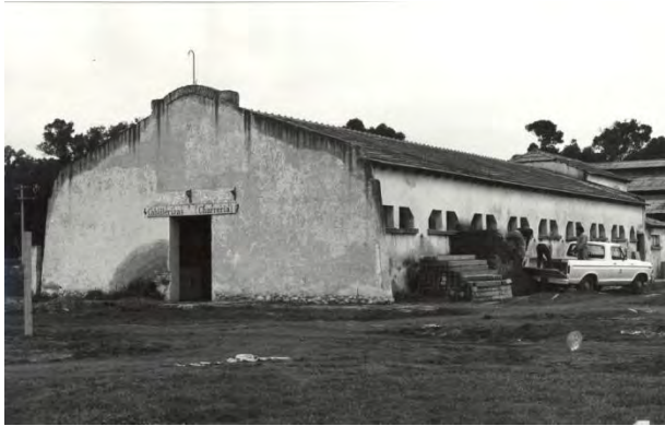
Figura 19. Caballerizas de la hacienda de Chapingo. Fuente: Anaya, 2004.
