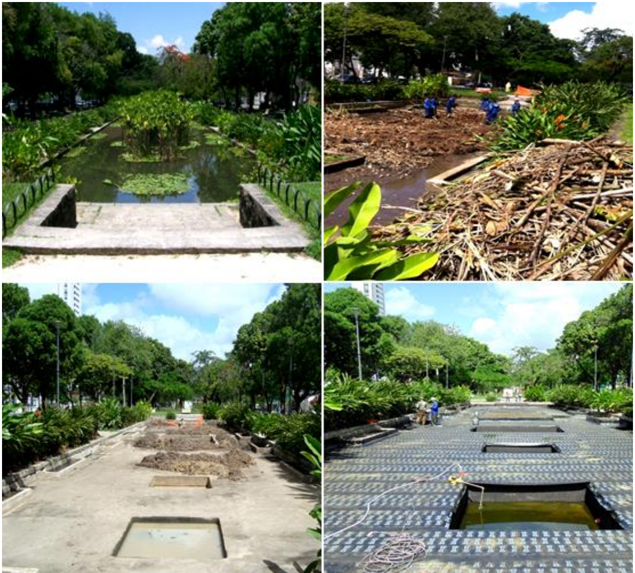
Figura 45: Plaza de Casa Forte, 2014. Lago de las plantas exóticas. Manejo de la vegetación; limpieza de las jardineras de plantas acuáticas y terrestres y impermeabilización.
