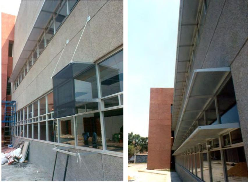
*Figura 5.* Sistema de protección solar mediante repisas metálicas y malla-sombra en edificio “P” de la UAM Azcapotzalco
