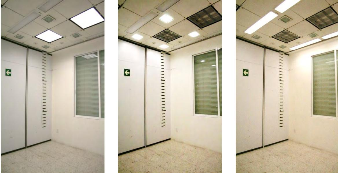
**Figura 58** .Izquierda-sistema de lámparas fluorescente tipo Curvalum, Centro- sistema con lámparas fluorescentes tipo compactas, Derecha- sistema con lámparas fluorescentes tipo lineal
