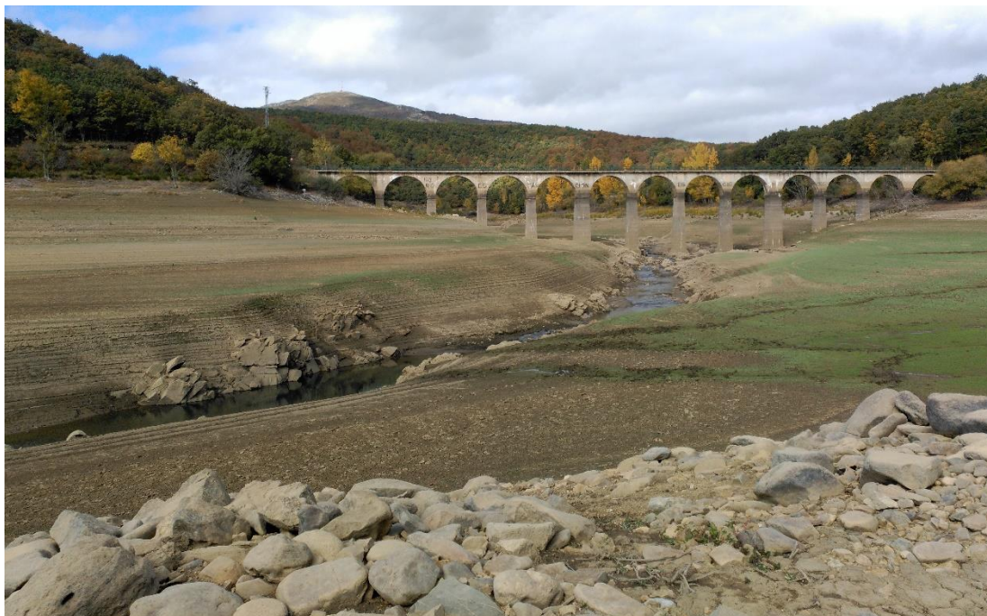
Figura 49. Terrazas del tramo inferior del Pisuerga en la cola del embalse de La Requejada
