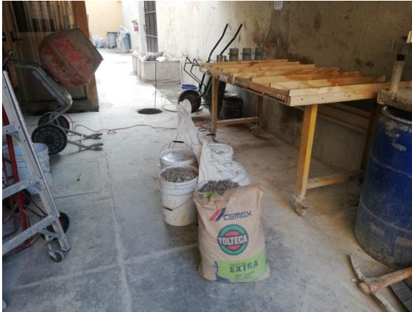
Figura 37: Materiales colado placas
