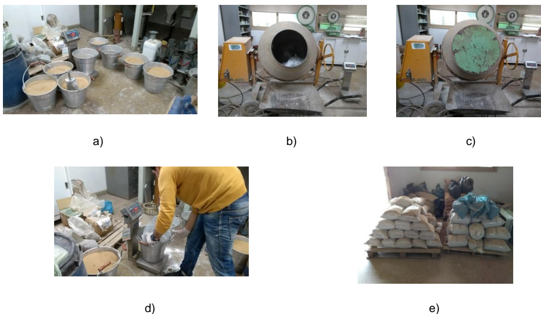
Figura 24: seqüência de dosagem dos traços das argamassas de projeção; a) preparação dos materiais, colocação dos materiais na betoneira, homogeneização dos materiais, d) material sendo pesado e ensacado, e) acondicionamento em paletes de madeira
