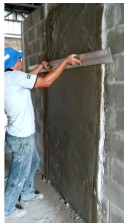
b) aplicação da régua tipo H
