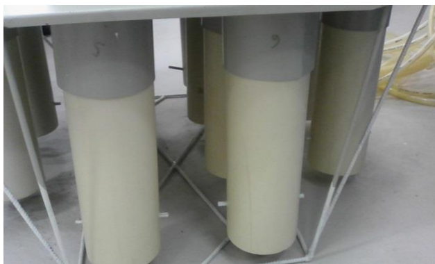
Figura 31 - Gasómetros con las trabas instaladas.
