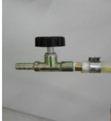
Figura 27 - Canilla de gas para extracción de biogás.
