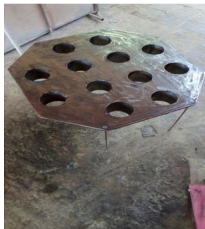
Figura 28 - Construcción del soporte metálico.
