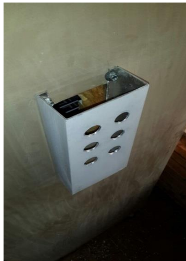
Figura 3 - Agujeros para los caños de gas.
