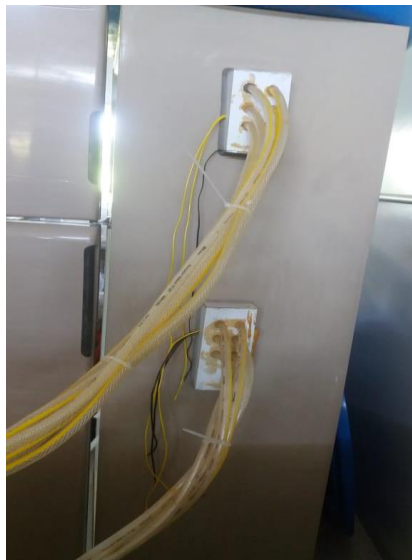
Figura 5 - Colocación de los caños de gas e cables de alimentación.
