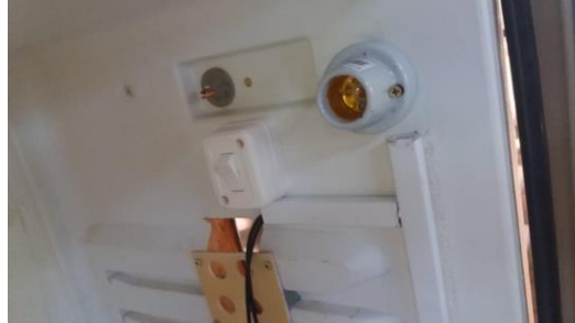
Figura 20 - Instalación del portalámparas e interruptor.
