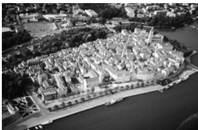
20. Prekrasan pogled na Trogir iz aviona redovne zračne linije dokazuje ujedno u kakvoj nedopustivoj i po spomenik katastrofalnoj blizini »zaštićenog« grada prolazi redovna zračna linija do aerodroma, ugrožavajući zvonik katedrale vibracijama i zagađivanjem
