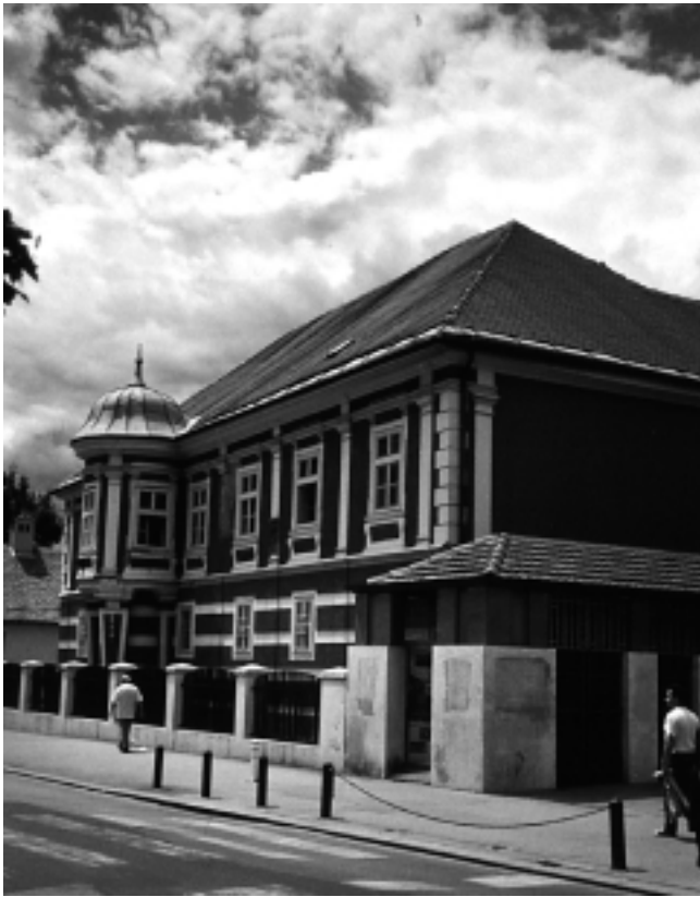
24. Barokna kanonička kurija s karakterističnim valjkastim istakom, na zagrebačkom Kaptolu, unakažena agresivno prigradenom recentnom prigradnjom ruralnog karaktera
