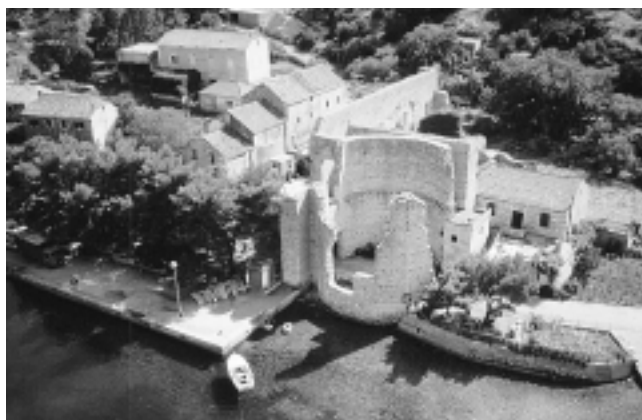
21. Ranobizantinska utvrda i palača, VI. st., u Polačama na otoku Mljetu, s divljom izgradnjom uokolo i unutar samog spomenika, ugrožena je i devastirana
