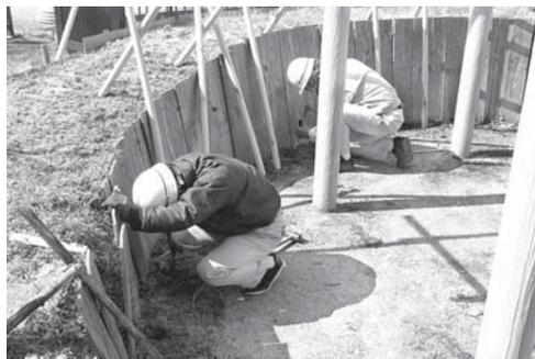
写真 41 矢板留支柱掘り方掘削状況
