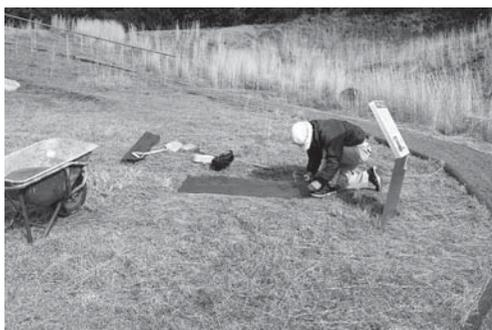
写真 44 透水性保護シートの固定状況
