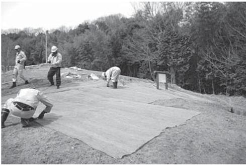
写真 48 ティフブレアシート設置作業 1
