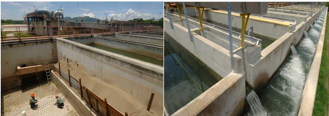
Planta Potabilizadora de Las Pavas.
