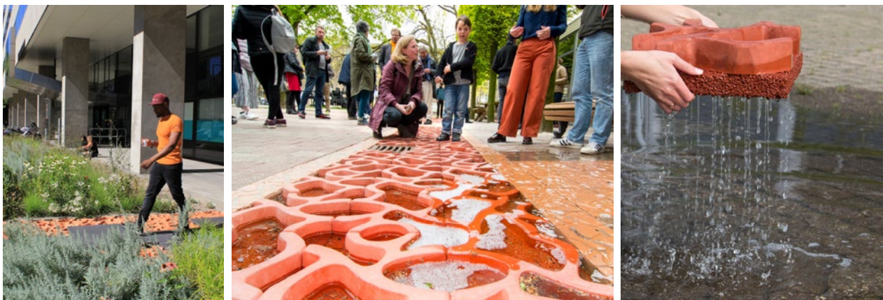
Figura 1: Rain(a)Way Katshoek Garden in Rotterdam. Il pavimento "Flood Permeable", è composto da due diversi tipi di calcestruzzo. Lo strato inferiore in calcestruzzo drenante consente all'acqua piovana di filtrare lentamente nel terreno, mentre le vaschette dello strato superiore accumulano acqua permettendo agli utenti di poter camminare liberamente. Fonte: Rain(a)Way
