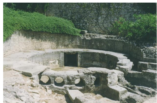
Figure I.5 : Le castellum du Pont du Gard à Nîmes. Source : Przemysław Sakrajda, 2010.
