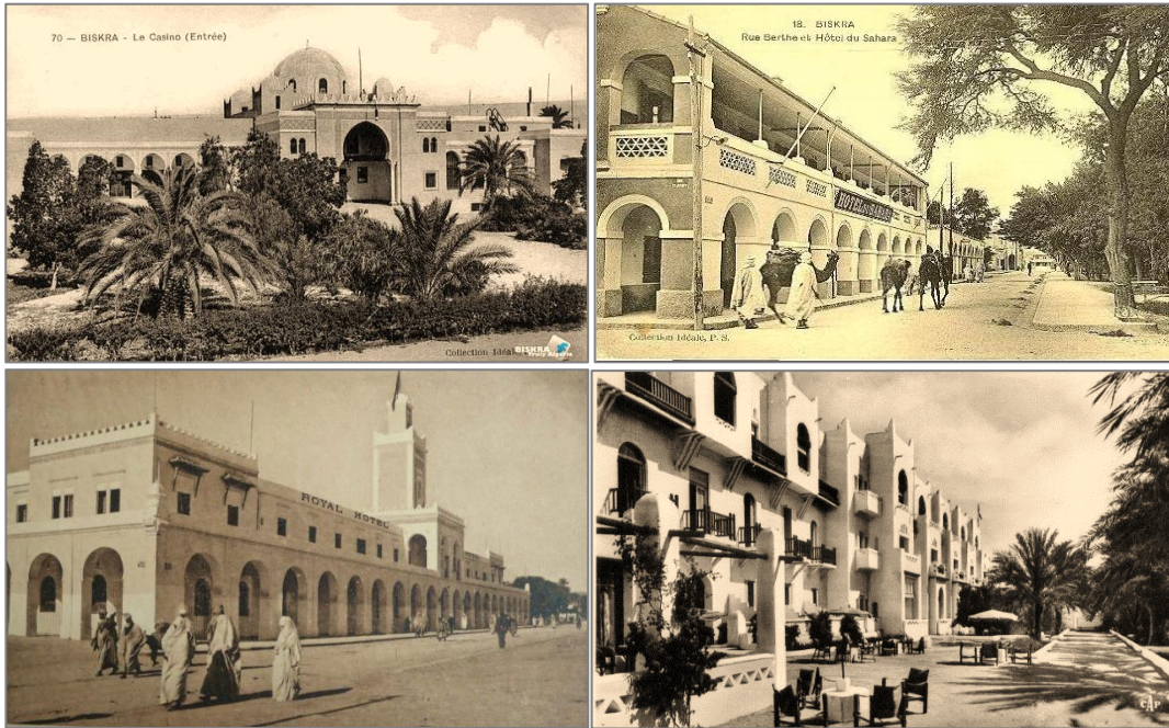
Figure IV.22 : Photos des : casino, et Hôtels ; Le Sahara, Le royal et Le Transatlantique. Source : Direction de l'urbanisme, commune de Biskra 2017.
