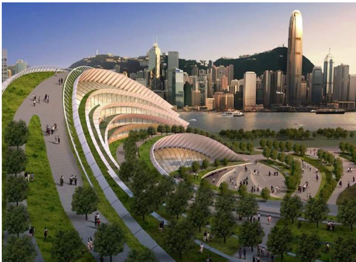
Слика 1.5. Екстериерен дизајн на покривот на подземната железничка станица во Хонг Конг, Кина
