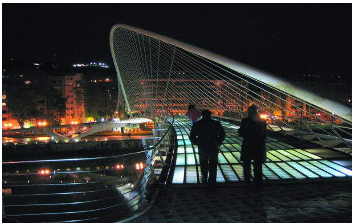
Слика 2.46. Пешачки мост Campo Volantin (1994-1997) во Билбао, Шпанија. Мостот Alamillo (1987-1992), изграден за Експо'92, Севиља, Шпанија, веднаш го привлече меѓународното внимание со впечатливиот 142 метри висок пилон, под агол од 58°, кој е доволно масивен за да го урамнотежи мостот, без потпори, само со 13 пара на кабли.
