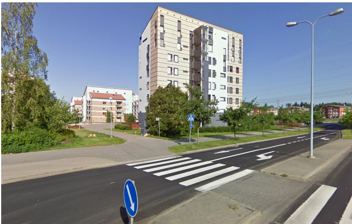
Kuva 29 Raitille pääseminen vaatii usein ajamista suojausten päältä (Google street view 2019).
