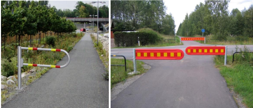
Kuva 11 Avaimella asentoon lukittava puolipuomi (Trafino Oy). Kuva 12 Jousimekanismilla työnnettävä avautuva puolipuomi (Trafino Oy).
