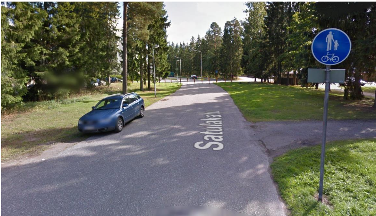
Kuva 37 Yhdistetyn pyörä- ja kävelytien ja ajoradan välinen visuaalinen ero on liikennemerkin ja ajoesteiden varassa (Google Street View 2019). Kuva on vuodelta 2009, nykyään sulkupylväiden tilalla on ajoesteaineiston mukaan nouseva pollari.
