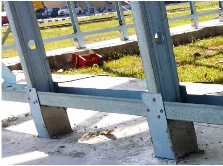
(d) Base connection on site
