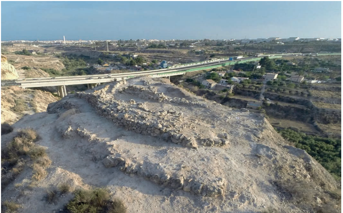
Figura 18. Vista de pájaro desde el noreste de Caramoro I efectuada con un dron. En primer término, el bastión 2006 y la zona de acceso.
