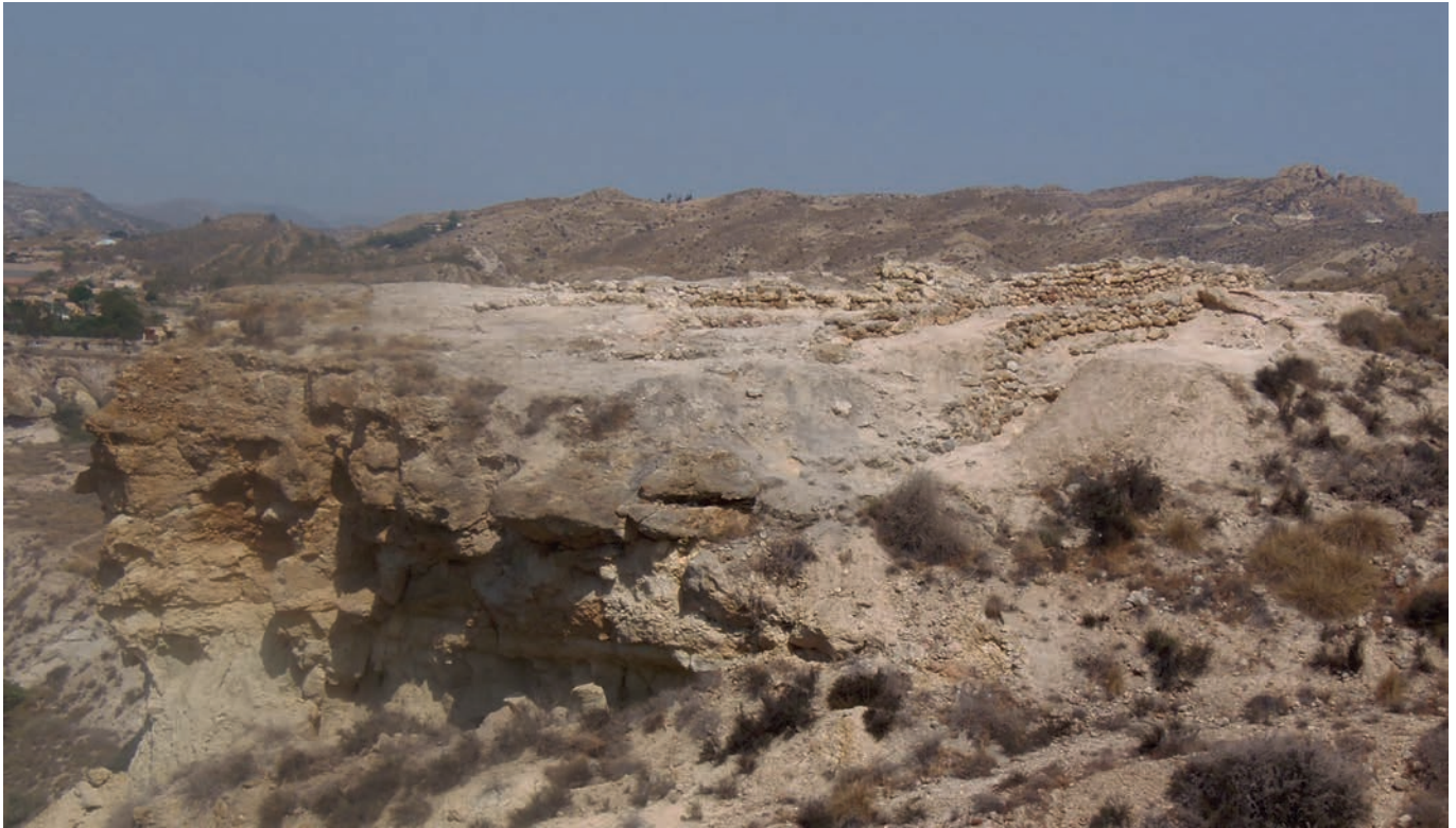
Figura 10. Vista exterior desde el sureste del antemural y muro principal de Caramoro I.
