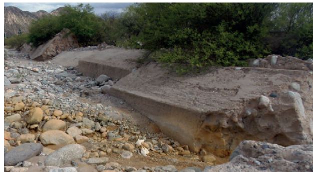
Figura 4 (superior). Detalle del muro actual volcado y destruido por la actividad erosiva
