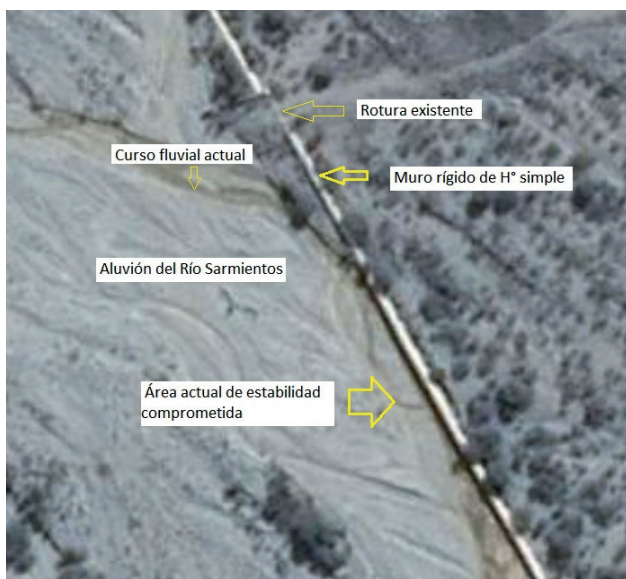
Figura 3 (izquierda). Muro en el río Sarmientos
