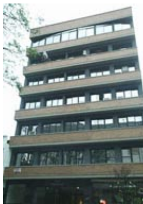
Figura 8: Edificio frente Este
