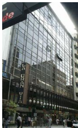
Figura 7: Edificio frente Sur
