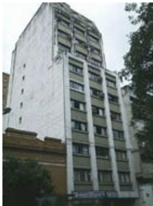
Figura 2: Edificio con menor superficie vidriada (aproximadamente 50% de la fachada)
