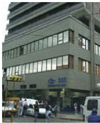
Figura 9: Edificio frentes Norte y Oeste
