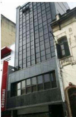
Figura 6: Edificio frente Norte
